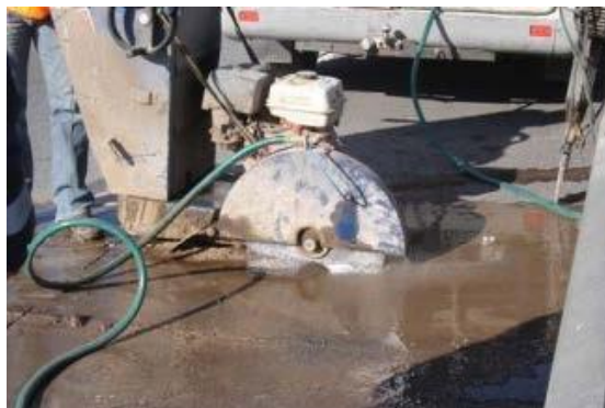
Figura 758 - 2. Aserrado para la toma de un testigo del pavimento
